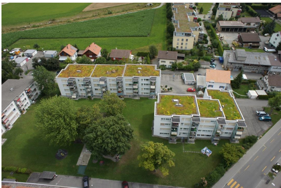
Toits végétalisés à Bâle (Emanuel Ammon)
